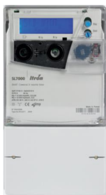
Figura 22 - Exemplo de contador totalizador disponível no mercado (Fonte: rolearmais.pt)
