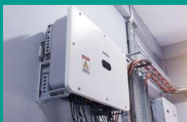
iv) Conversores / inversores 5 (especialmente no solar)
